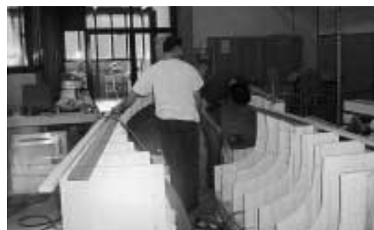
Die 4 Schalungsteile wurden einzeln angefertigt und später zusammengefügt.
