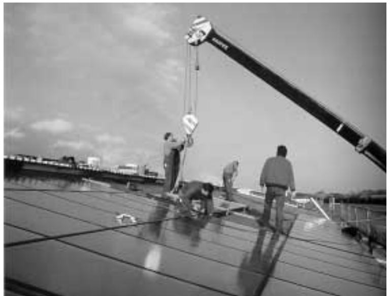
Abb. 5: Montage einer Kollektoranlage auf dem Dach
