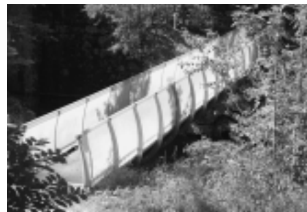
Brücke über die Kempt, Winterthur, Montiert durch ZHW-Bauingenieurstudenten
