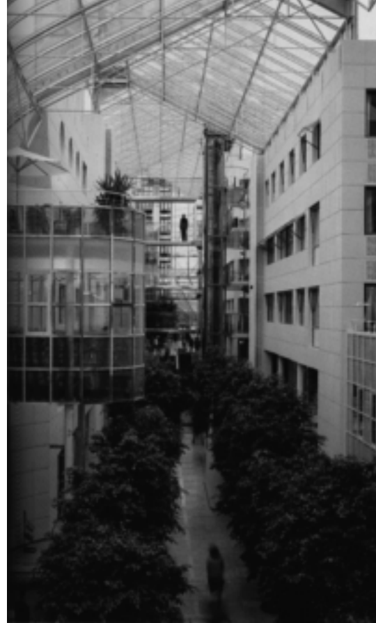
Atrium in der Hauptverwaltung der Scandinavian Airlines Systems in Stockholm. Architekt: Niels Torp
