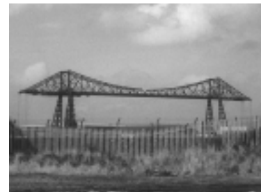
Stahlbrückenkonstruktion über den Tees
