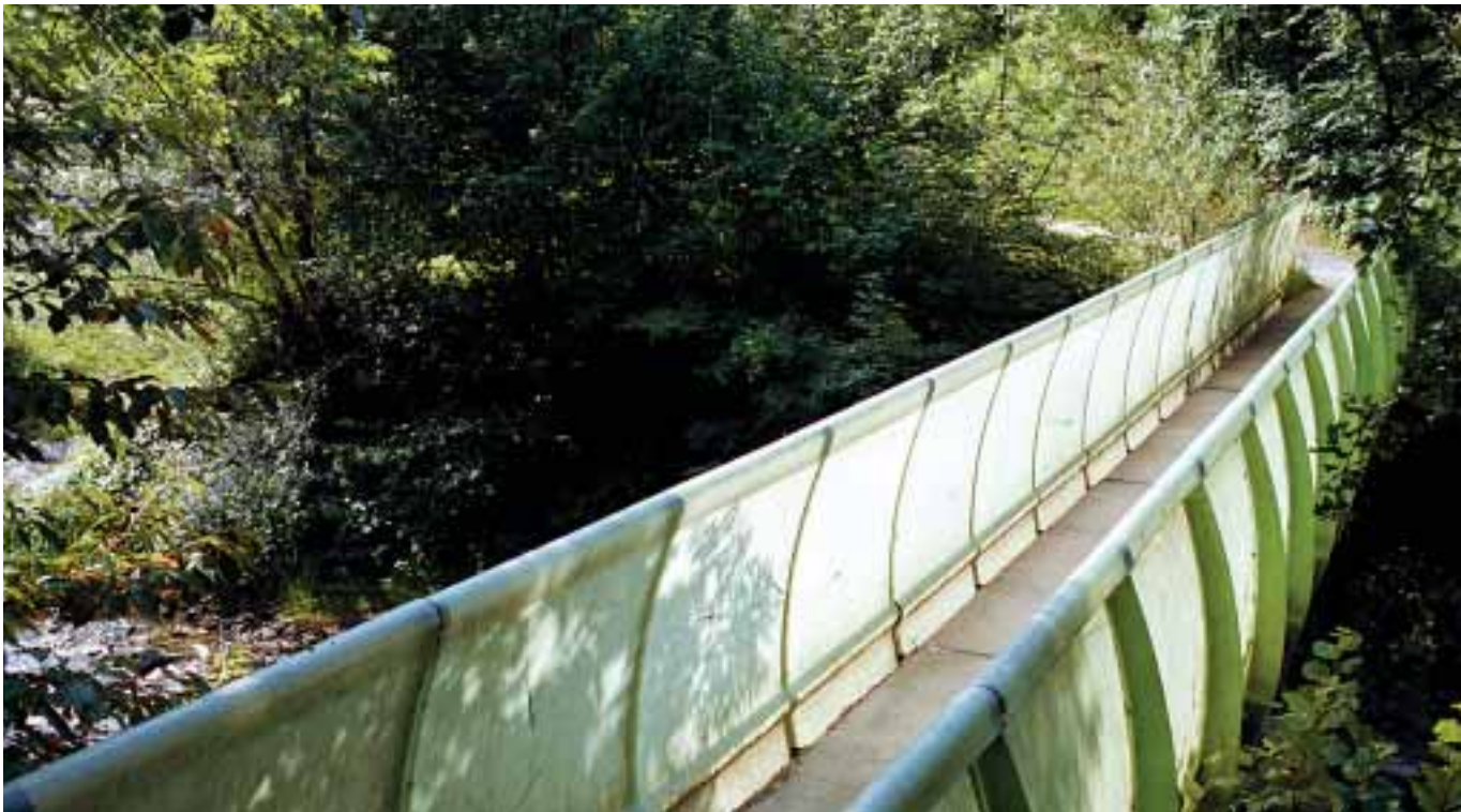
Der Prototyp einer mit Glasfasern verstärkten Kunststoffbrücke führt über die Kempt bei Winterthur. Das Material kann weder faulen wie Holz noch rosten wie Stahl.
