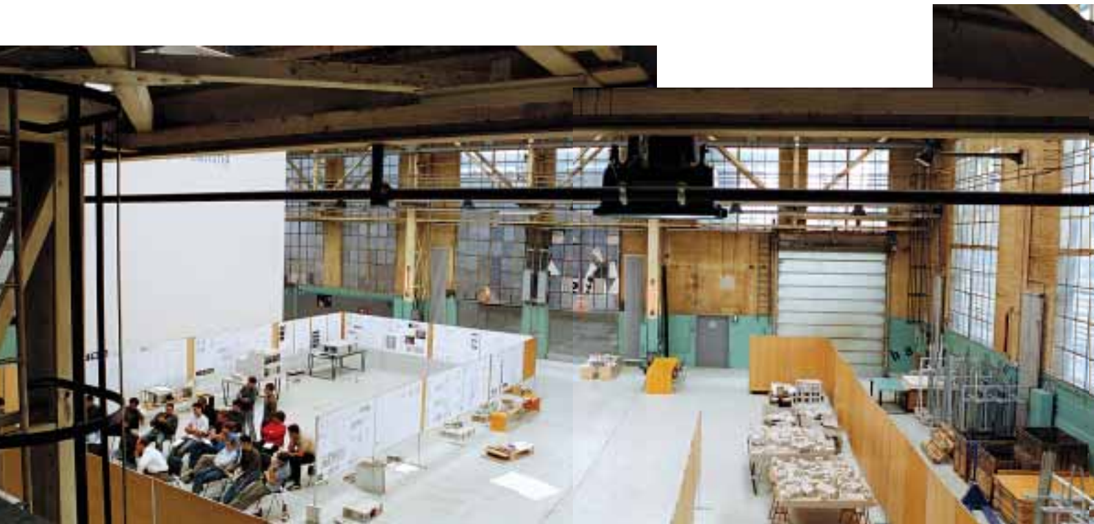
In der Architekturhalle wurden früher Turbinen montiert. Heute bietet der riesige Raum durch geschickte Unterteilung Platz für Vorlesungen und Ausstellungen. Auf dem Bild nicht zu sehen sind die wabenartig und über mehrere Etagen ineinander verschachtelten Arbeitsräume für Dozierende und Studierende.
