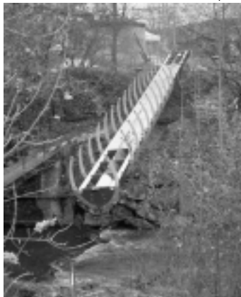
Einbau des Versuchsstegs über die Kempt in Winterthur
