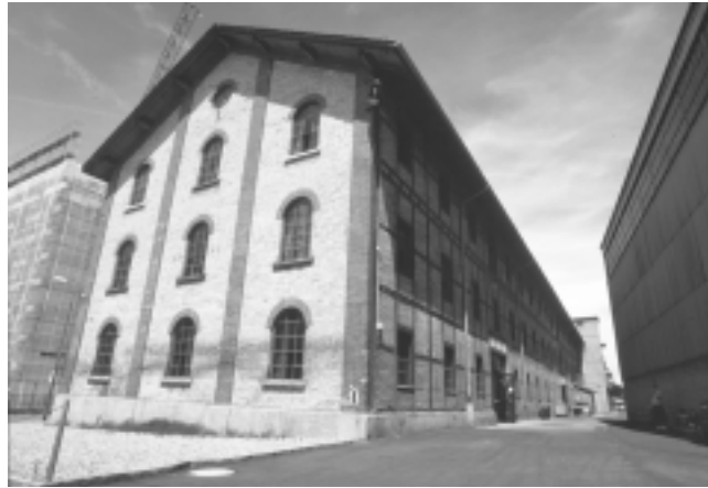
Kesselschmiede im Tössfeld, Standort des IAM
