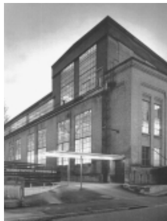
Halle 180 am ZHW-Standort Tössfeld
